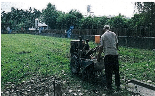
說明:翻土整地
